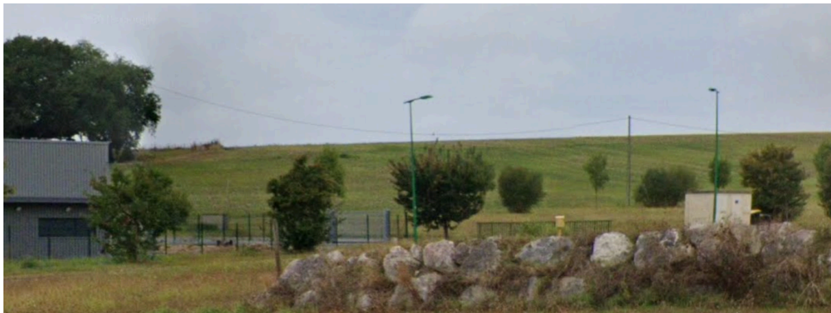
Illustration 15 : Vue aérienne de la zone d'études ; Clôture, éclairage, UrbaDoc; Mai 2020
