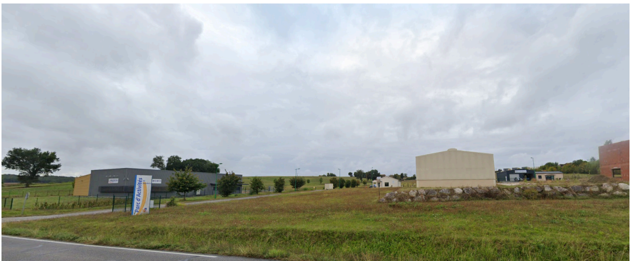
Illustrations 8 : Constructions à l'intérieur de la zone d'étude ; Google Maps ; Mai 2020
